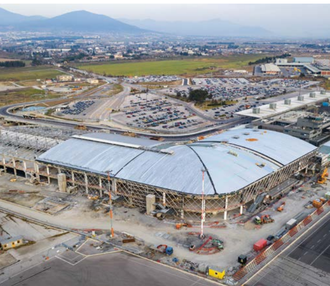
In Thessaloniki entsteht für rund 100 Mio € ein neues Terminal.
