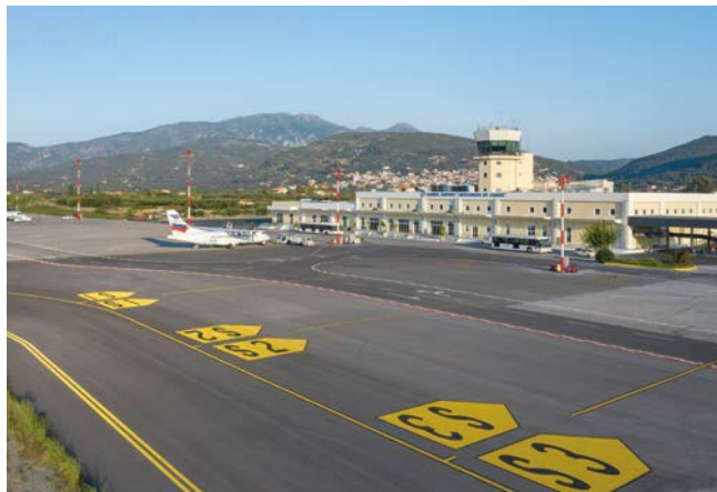
Die Baumaßnahmen am griechischen Flughafen Samos wurden zeitgerecht abgeschlossen.
