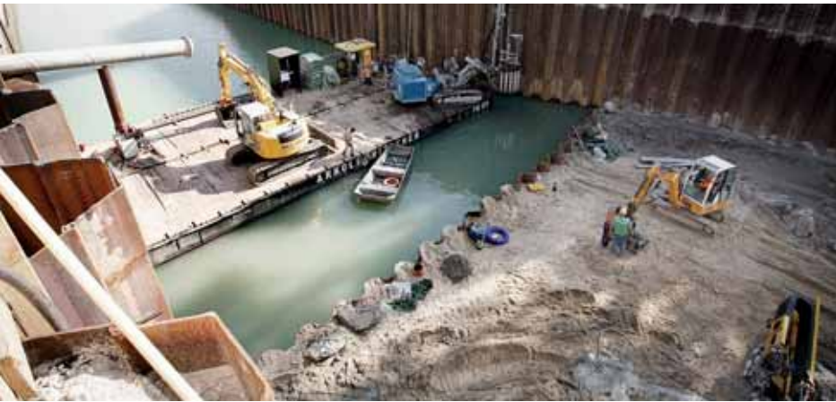
Tunnelbauarbeiten für die neue Landebahn Nordwest
