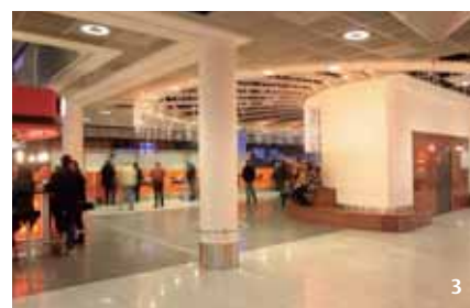
1 Blick auf die Decke des Terminals 1: Im Vordergrund der bereits modernisierte Teil, rechts im Hintergrund Arbeitsbühnen die für die Modernisierung der Decke eingesetzt werden
