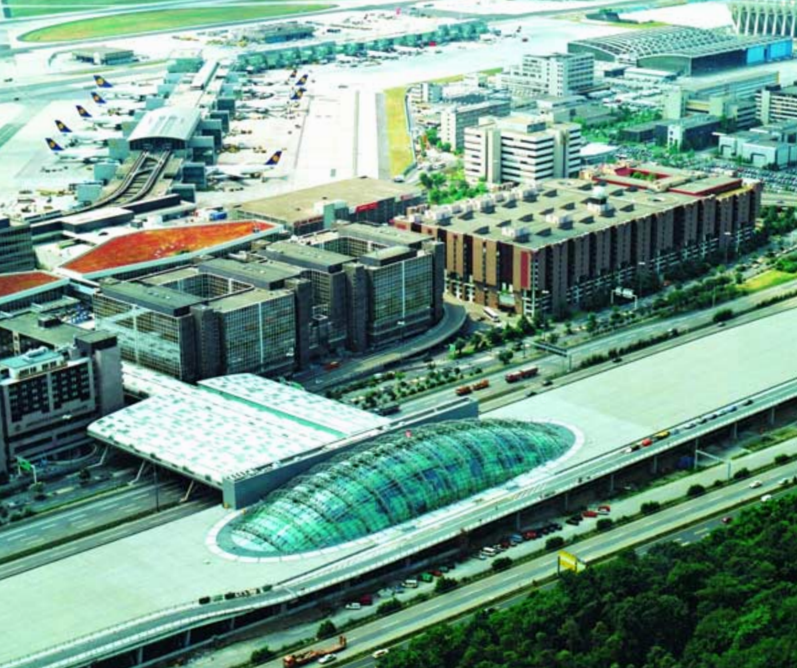
Blick auf Fernbahnhof und Terminal 1.
